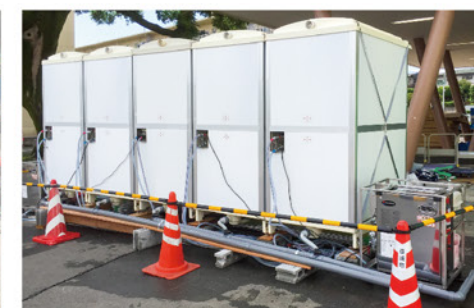
所定の排水勾配をとり排水路へ
